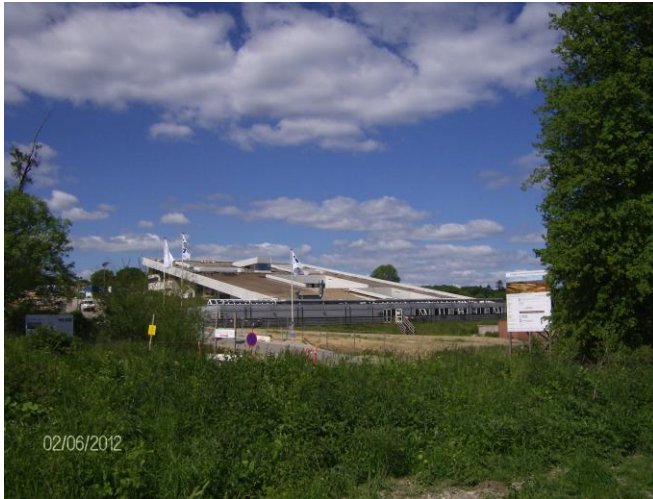
Bauplatz des neuen Moesgaard Museums
