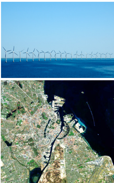
Fig. 1. Wind farm Middelgrunden 2km east of Copenhagen.
