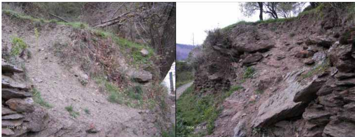
Bild 5.1 Erosionserscheinungen an verfallenen Terrassen durch heruntergebrochene Mauern
